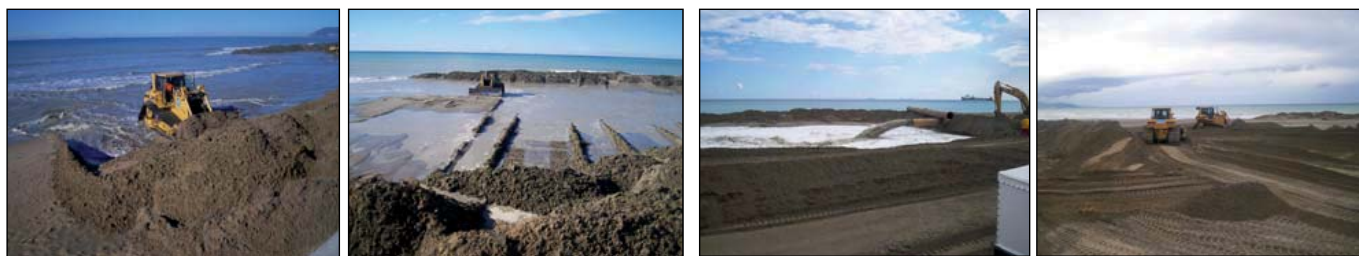
Figura 3 – Fasi di lavorazione per il ripascimento del tratto tra Porto Badino e Via Friuli Venezia Giulia (estratto da www.forum-macchine.it ).
