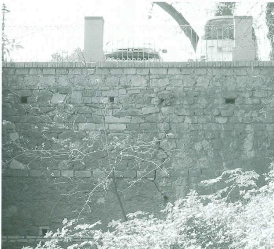
Figura 6 - Lesioni sul muro di contenimento del piazzale antistante Villa Mazzanti.
