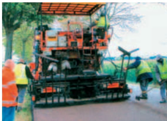
A fianco: cantiere e messa in opera del conglomerato bituminoso
