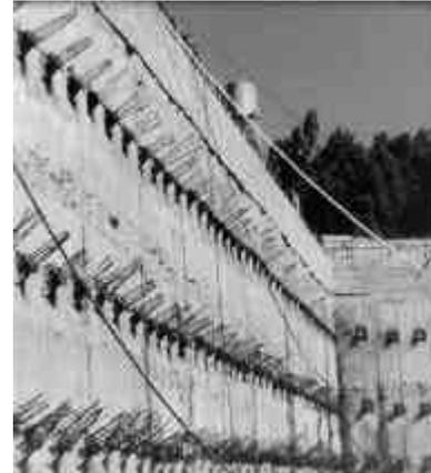
*Fig. 9 Italia. Latina. Impianto nucleare di Cirene 1975. Scavo di fondazione della centrale realizzato mediante diaframmi continui in c.a. ancorati in profondità con tiranti attivi*
