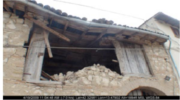
(d) Out-of-plane masonry wall failure
