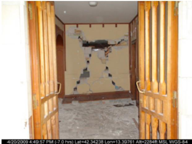
(d) Diagonal crack failure of the infill wall
