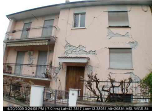
(d) Moderate damage in a building façade
