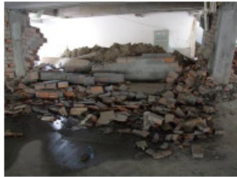
(d) Out-of-plane infill wall failure
