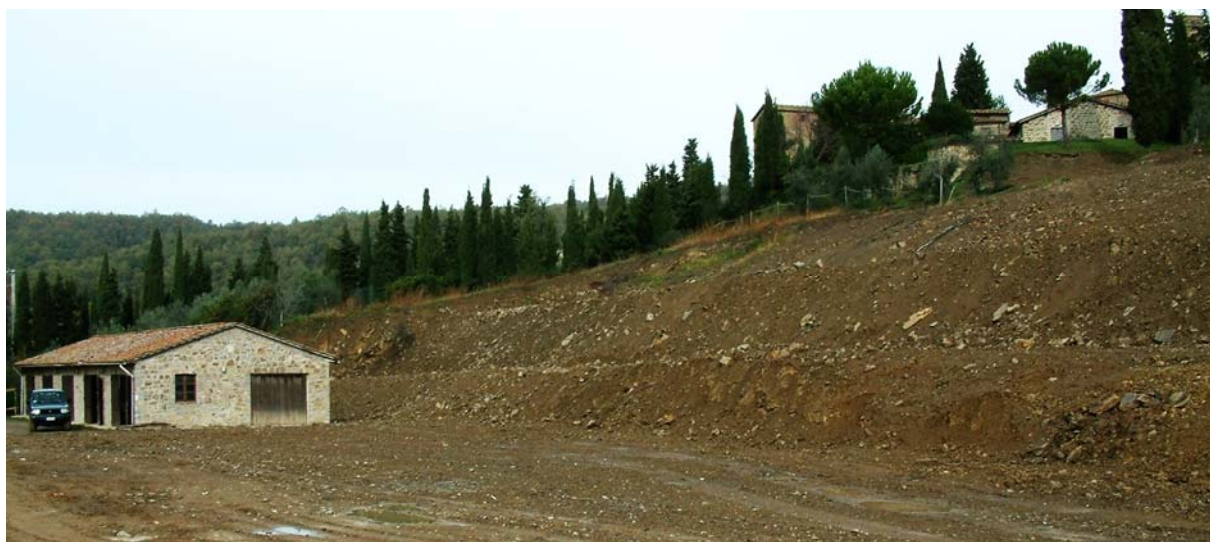
Fig. 10 - Sistemazione di un movimento franoso in località Volpaia nel comune di Radda in Chianti (FI) ottenuto caricando il piede del versante con il materiale scaricato in testa (novembre 2002) -
