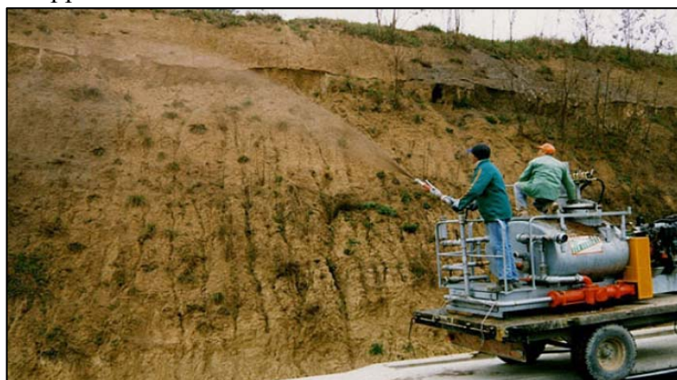
Fig. 19 – Inerbimento di una scarpata tramite idrosemina: l'idroseminatrice è montata su un camioncino ed è munita di lancia girevole, che permette l'aspersione della miscela sulla superficie da trattare (da ANPA, 2002) -
