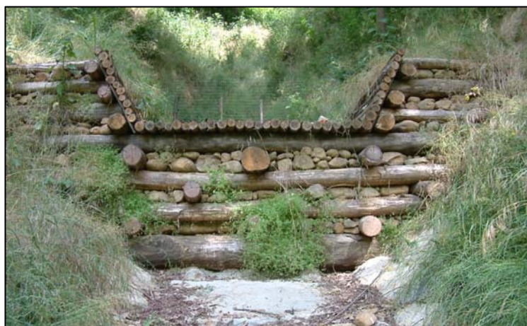
Fig. 118 –Particolare di una briglia in legname e pietrame realizzata nella porzione sommitale di un'impluvio nei pressi di Reggello (FI) -
