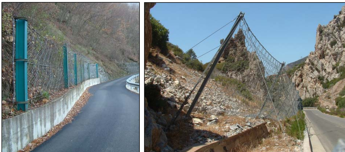
Fig. 131 – Barriere paramassi elastiche: verticale a sinistra e a sacco a destra -
