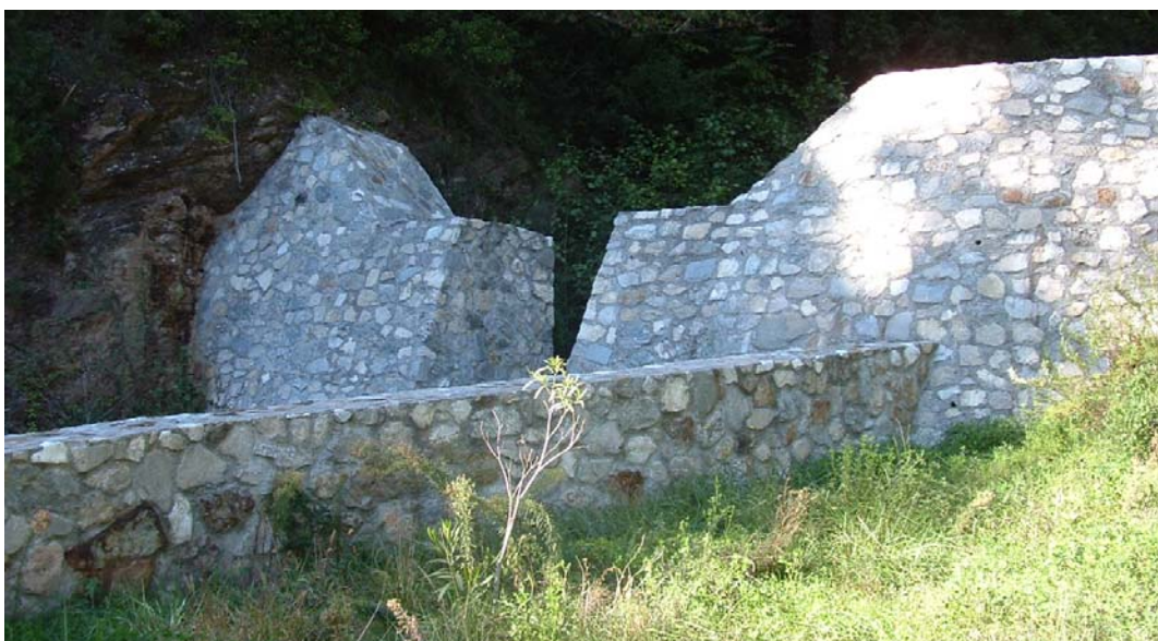
Fig. 126 – Struttura di ritenuta realizzata lungo un'impluvio nei pressi di Seravezza (LU) -
