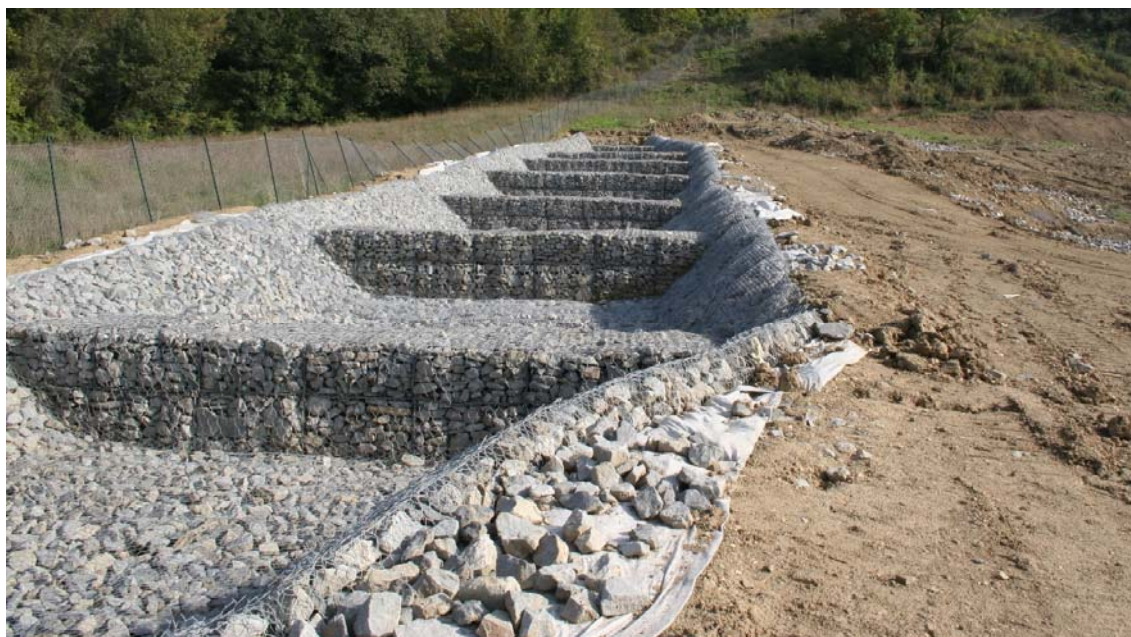
Fig. 40 – Particolare di un fosso di perimetrazione laterale costruito tramite gabbioni e materassi tipo Reno in località Acquatesa nel comune di Barberino di Mugello (FI) nel corso dei lavori connessi con la realizzazione Variante di Valico dell'autostrada A1 -
