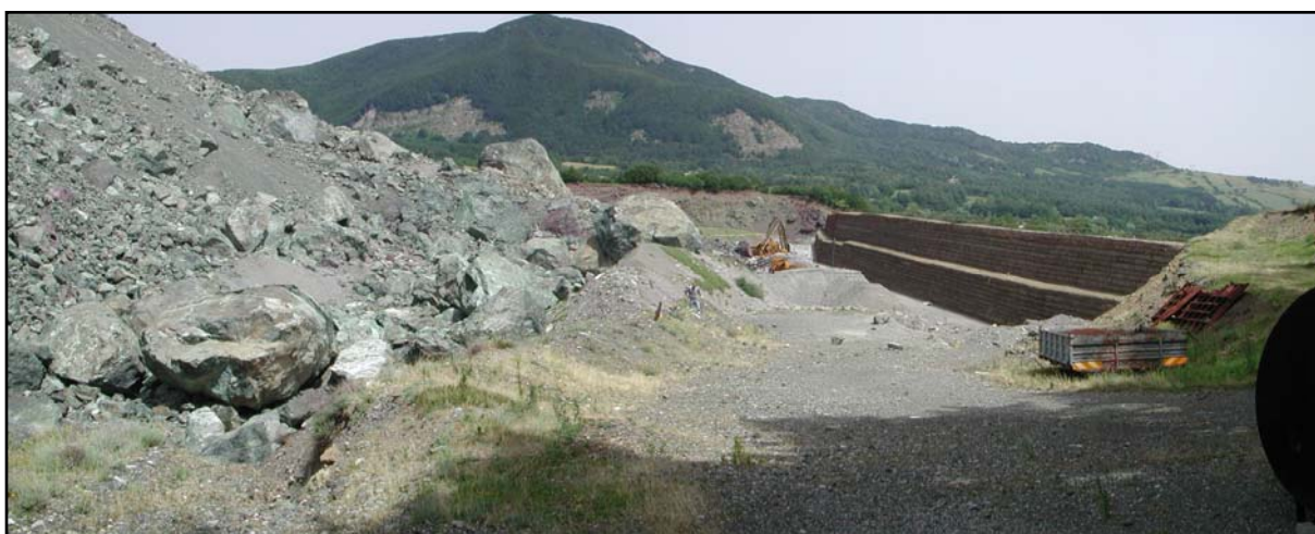
Fig. 133 – Rilevato paramassi realizzato in corrispondenza del versante orientale del Monte Beni, nel comune di Firenzuola (FI). La struttura di difesa alta 12 m è in grado di assorbire energie di impatto superiori a 10000 kJ; il nucleo centrale e il lato a monte del rilevato sono realizzati in terra rinforzata, mentre il paramento di valle è costituito da semplici strati di terra compattata -
