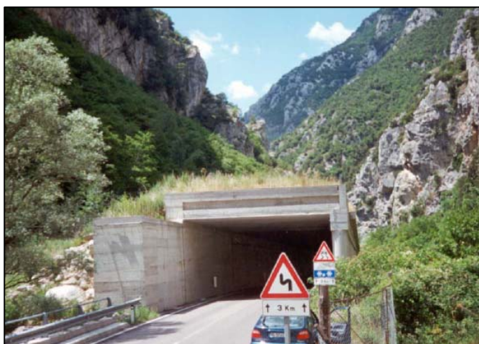
Fig. 135 – Galleria paramassi realizzata a protezione di un tratto stradale; si può notare il materiale detritico posto sulla volta e sul lato di monte (a sinistra) con lo scopo sia di attutire l'impatto dei blocchi che di mitigare il vistoso impatto ambientale della struttura, favorendo lo sviluppo di vegetazione a crescita spontanea -
