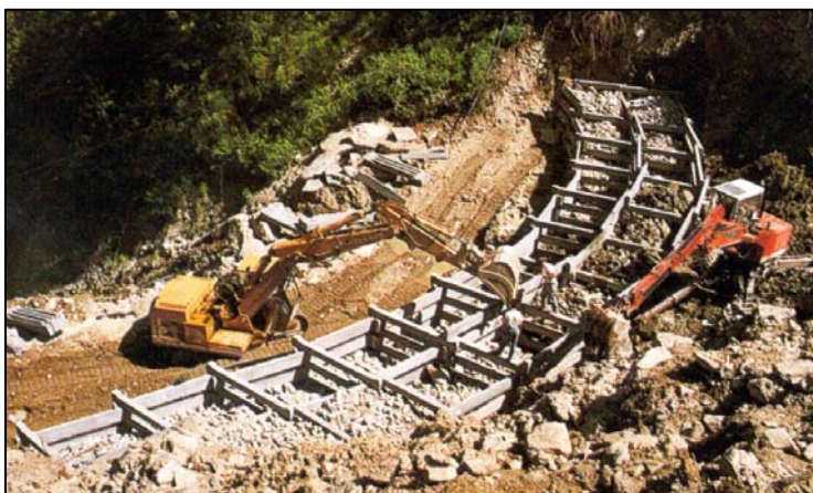
Fig. 72 – Fase di completamento (riempimento delle maglie con materiale lapideo prelevato in sito) di un muro cellulare in travetti in calcestruzzo (da ANPA, 2002) -
