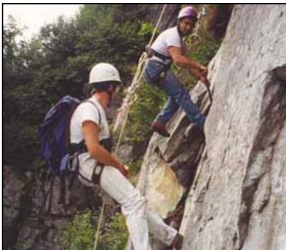
Fig. 114 – Disgaggio di blocchi instabili eseguito da arrampicatori utilizzando leve e cunei -
