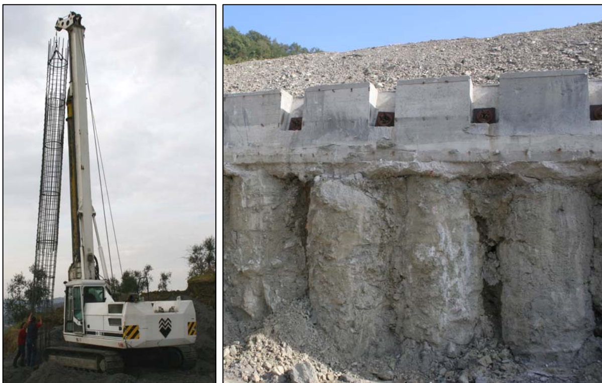
Fig. 84 – A sinistra dettaglio della fase di posa dell'armatura di una palificata di pali di grosso diametro (800mm) durante un intervento di stabilizzazione in località Carbonile nel comune di Pelago (FI). A destra dettaglio della porzione superiore di una palificata di pali di grosso diametro realizzata in località Poggiolino nel comune di Barberino di Mugello (FI) in occasione dei lavori per la realizzazione della Variante di Valico dell'autostrada A1; è visibile la trave tirantata di collegamento in testa dei pali -
