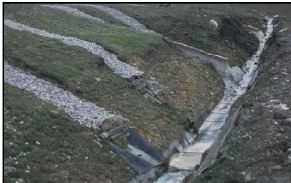
Fig. 44 – Stabilizzazione di un versante mediante trincee drenanti; le trincee disposte secondo il pendio confluiscono in una canaletta rivestita con elementi in calcestruzzo, che convoglia lo scarico dei dreni al di fuori dell'area (da ANPA, 2002) -
