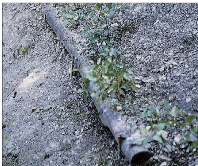
Fig. 30 – Particolare di una palizzata realizzata per la stabilizzazione di una scarpata stradale a Fumeri nel comune di Mignanego (GE). In questo caso i pali trasversali sono fissati direttamente a tondini di acciaio infissi nel terreno; nel gradone a tergo dei pali trasversali sono state messe a dimora piantine in fitocella (da REGIONE LIGURIA, 1997) -
