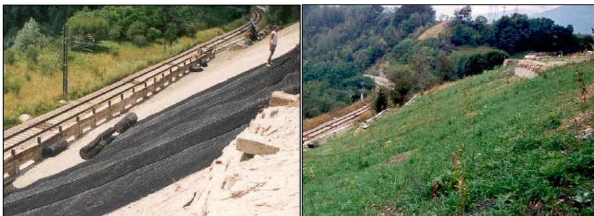
Fig. 13 – Impiego di geotessuto rinforzata con rete metallica, per la stabilizzazione ed il rinverdimento di un versante argilloso: a sinistra fase di posa; a destra situazione dopo l'idrosemina (da ANPA, 2002) -
