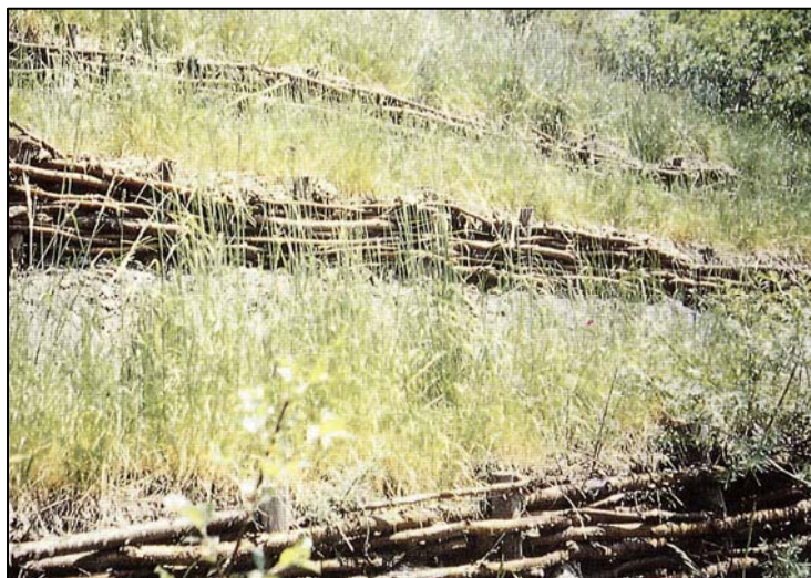
Fig. 28 – Intervento di stabilizzazione di una scarpata tramite graticciate ed inerbimento con specie locali, in località Rocca d'Aveto nel comune di S. Stefano d'Aveto, provincia di Genova (da REGIONE LIGURIA, 1997) -
