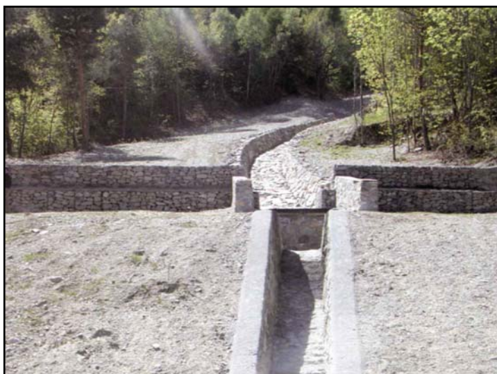
Fig. 122 – Struttura di intercettazione in gabbioni e rete metallica a doppia torsione; al centro il canale rivestito in pietrame che convoglia le portate liquide (da ANPA, 2002) -
