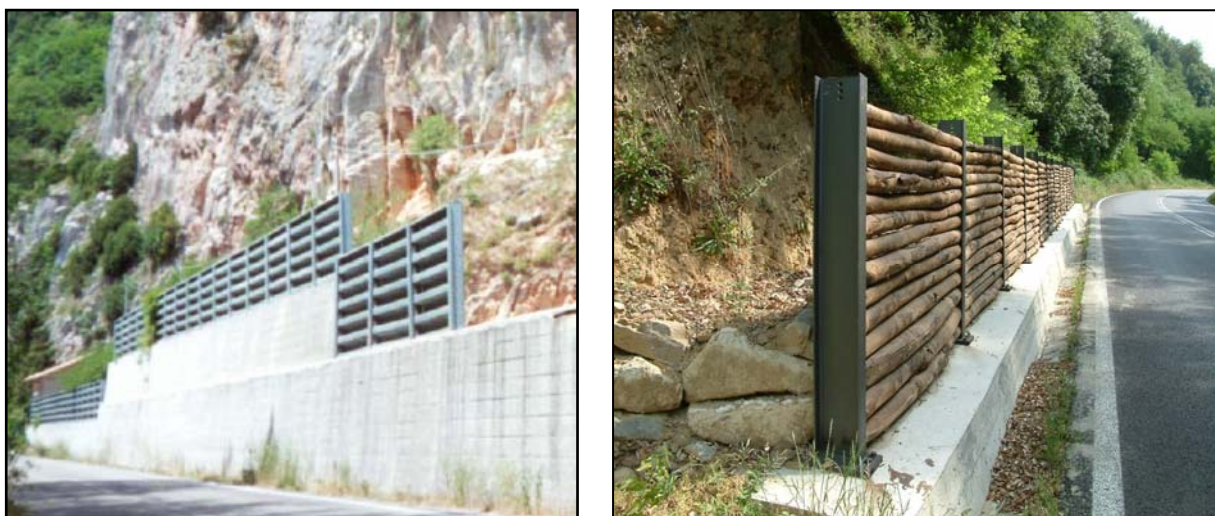
Fig. 132 – A sinistra barriera paramassi rigida in cemento armato sormontata, nei tratti più critici, da una barriera deformabile in pannelli metallici prefabbricati. Nel caso specifico, questo tipo di intervento è accoppiato al rivestimento della parete rocciosa retrostante con rete metallica (da ANPA 2002). A destra barriera rigida, costituita da pannelli in legname incastrati su travi metalliche a doppio T, per il controllo di crolli di materiale detritico in legname (comune di Reggello (FI) -
