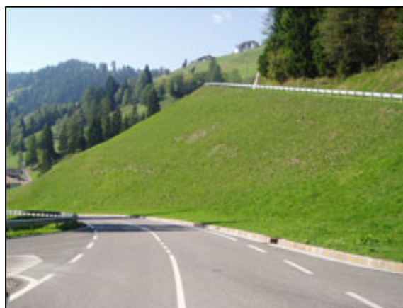
Fig. 18 – Intervento di semina nero-verde su una scarpata a Proves (BZ): a sinistra distribuzione dello strato di paglia e semina, a destra il risultato dopo tre mesi (immagini tratte dal sito internet www.Vandeborre.it ) -
