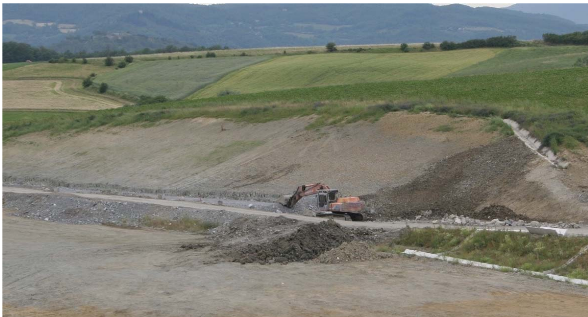
Fig. 7 – Stabilizzazione di un versante, tramite riduzione uniforme della pendenza e realizzazione di un fosso di guardia a monte, lungo la linea Treno Alta Velocità nei pressi di Scarperia in provincia di Firenze (giugno 2006), -
