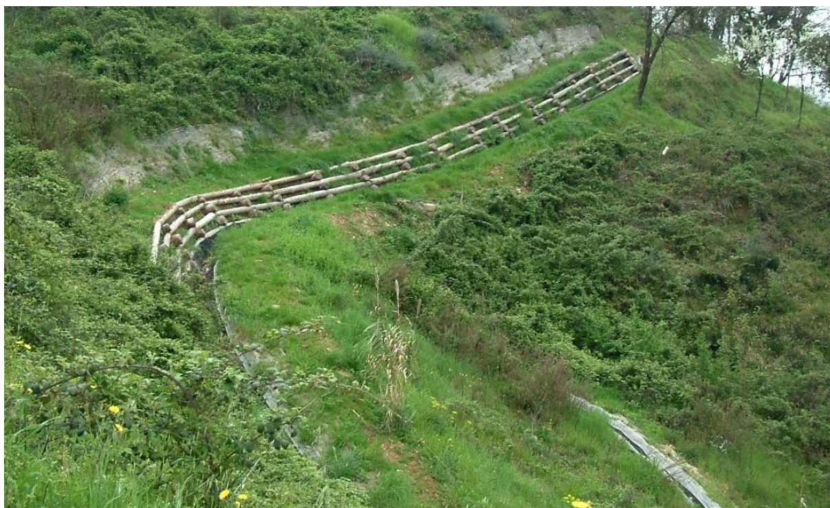
Fig. 31 – Utilizzo di palificate nella stabilizzazione di un versante in località Ricciano nel comune di Uzzano (PT) , la stabilizzazione è completa tramite rivestimento con biostuoie (B1b) e rinverdimento (B1c) -
