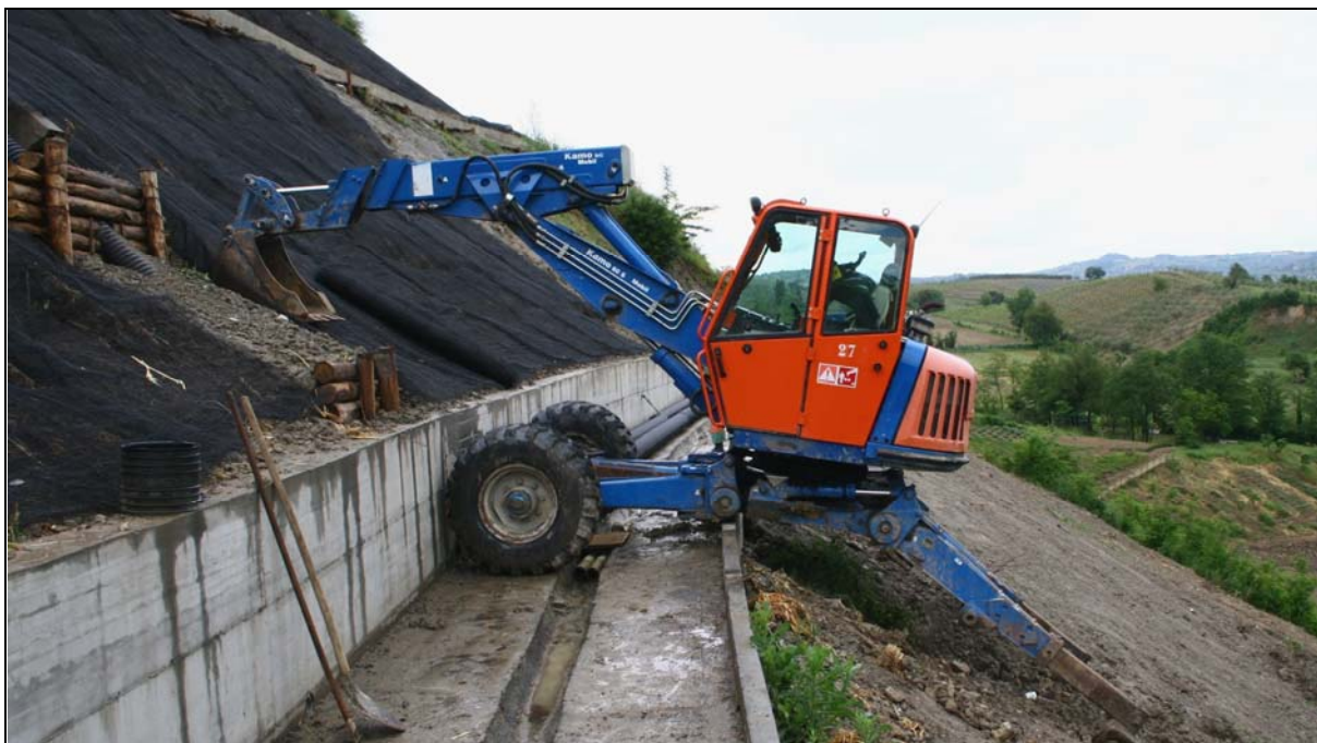
Fig. 14 – Posizionamento di geostuoie, tramite un “ragno” meccanizzato, durante gli interventi di sistemazione della scarpata sud di Certaldo Alto (FI). Le geostuoie sono fissate a canalette in cemento armato (B2a) fondate su micropali (D1c) che svolgono una duplice funzione di sostegno -
