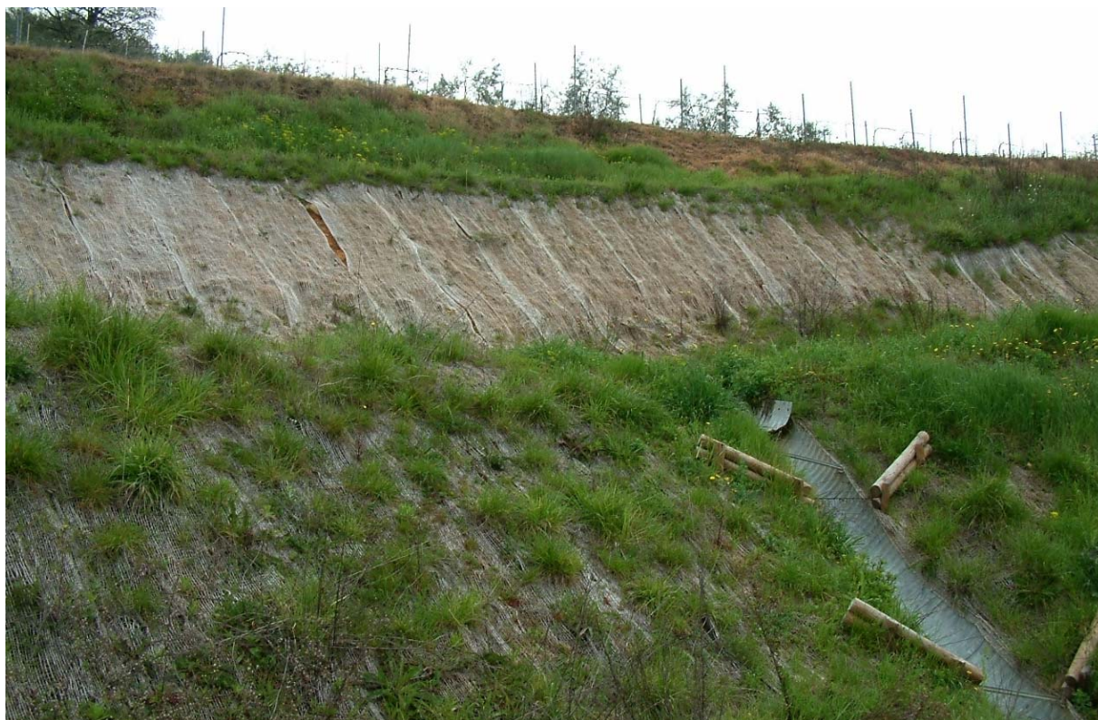
Fig. 17 – Stabilizzazione di un versante tramite rivestimento con biostuoie in località Ricuciano nel comune di Uzzano (PT). Il controllo dell'erosione e la regimazione delle acque superficiali è ottenuta anche per mezzo di cabalette prefabbricate in lamiera (intervento B2a) –
