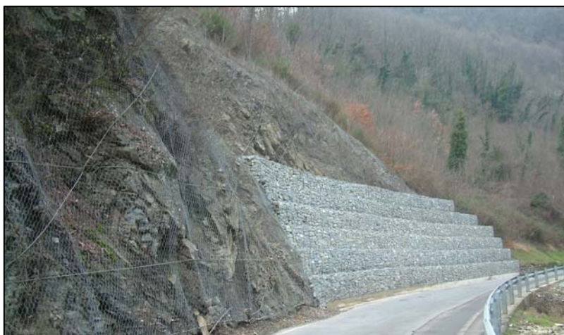
Fig. 71 - Stabilizzazione di una scarpata rocciosa lungo la strada comunale per Fondagnana (Comune di Vernio) tramite gabbionata e rete metallica a maglia esagonale a doppia torsione (Foto gennaio 2004) -
