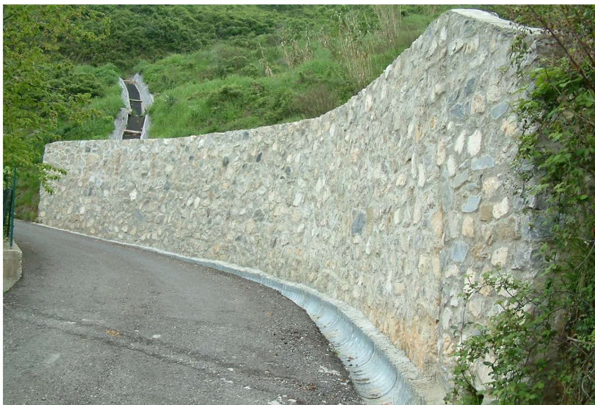
Fig. 65 - Muro di sostegno in calcestruzzo, rivestito con muratura in pietra, realizzato lungo la strada comunale "via Colli per Uzzano" (Comune di Uzzano, provincia di Pistoia) -
