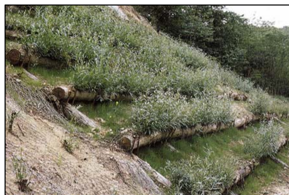
Fig. 34 – In alto rappresentazione schematica di una grata viva. In basso un intervento di stabilizzazione di una frana da scivolamento, lungo la linea ferroviaria Torino – Savona, effettuato tramite la realizzazione di una grata viva: a sinistra particolare della struttura e delle talee di salici; a destra opera a sei mesi dall'ultimazione (da REGIONE LIGURIA, 1997) -
