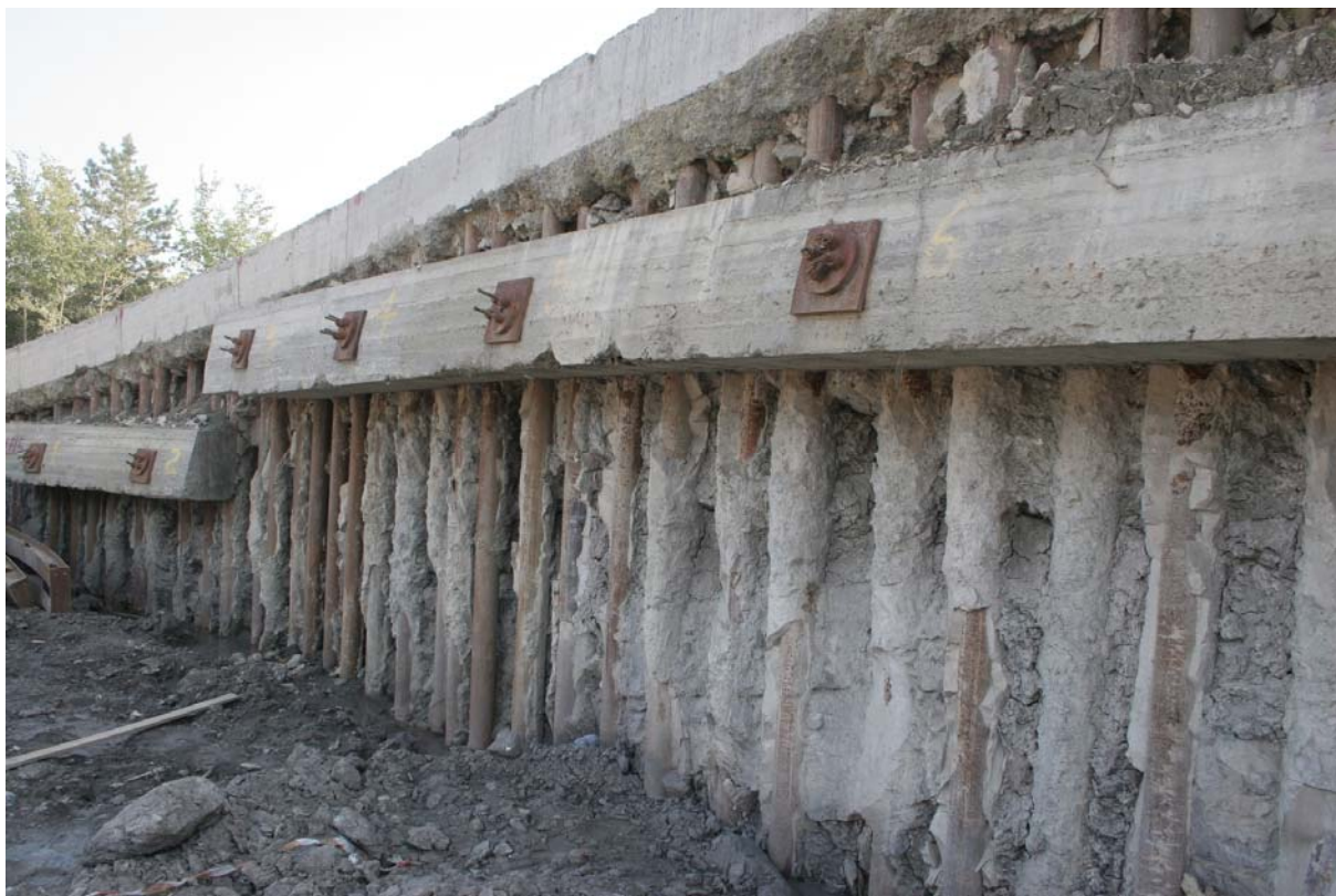
Fig. 81 – Paratia di micropali collegati in testa tramite cordolo in cemento armato e ancorati al substrato stabile tramite tiranti posizionati attraverso un ulteriore cordolo di collegamento in cemento armato. Intervento realizzato a Poggiolino nel comune di Barberino di Mugello (FI) durante i lavori connessi alla realizzazione della Variante di Valico dell'autostrada A1 (foto ottobre 2006) -
