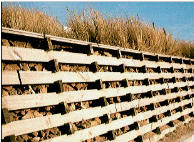
Fig. 74 – Muro cellulare con elementi in legno (Permacrib); benché solitamente gli elementi in legno vengano utilizzati per strutture temporanee, queste opere possono avere tempi di vita anche superiori ai 60 anni -
