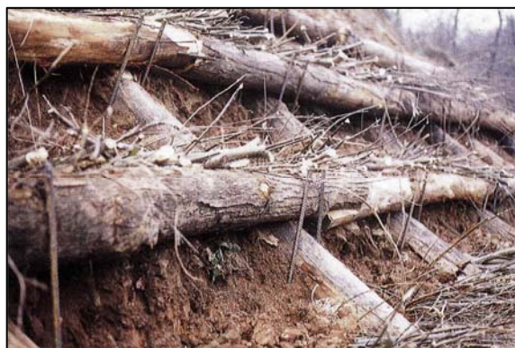
Fig. 34 – In alto rappresentazione schematica di una grata viva. In basso un intervento di stabilizzazione di una frana da scivolamento, lungo la linea ferroviaria Torino – Savona, effettuato tramite la realizzazione di una grata viva: a sinistra particolare della struttura e delle talee di salici; a destra opera a sei mesi dall'ultimazione (da REGIONE LIGURIA, 1997) -
