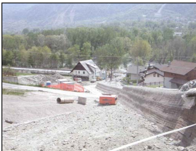
Fig. 121 – Barriera di diversione (Messigny, AO) a monte di un gruppo di case (da ANPA, 2002) -
