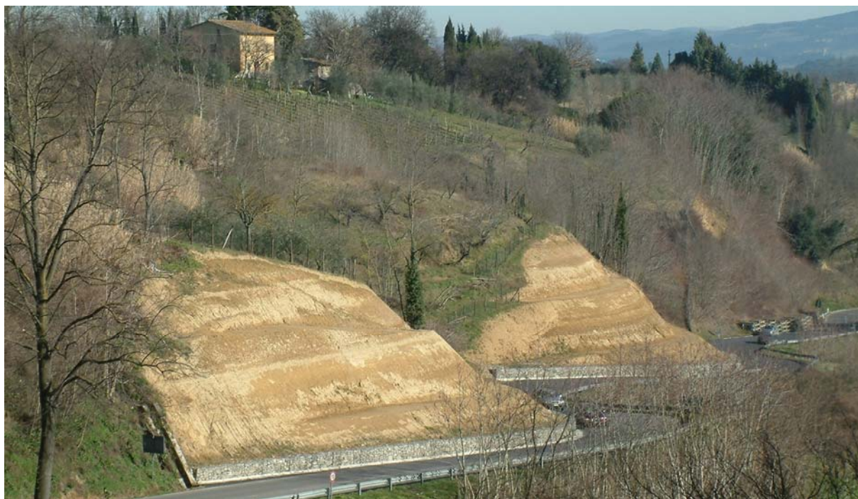
Fig. 12 - Stabilizzazione di un versante nei pressi di Colle Val d'Elsa (SI) tramite intervento di gradonatura (febbraio 2003) -
