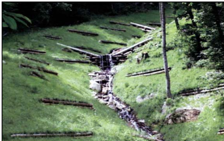
Fig. 128 – Rivestimento delle sponde di un torrente tramite intervento di rinverdimento e palizzate (da ANPA 2002) -
