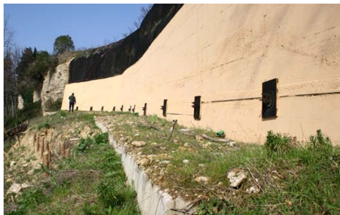
Fig. 89 – A sinistra sezione schematica di un muro tirantato; la linea rossa tratteggiata rappresenta la superficie di scivolamento. A destra muro di sostegno tirantato, realizzato per la stabilizzazione del versante nord-ovest di Marcialla nel comune di Certaldo (FI) -
