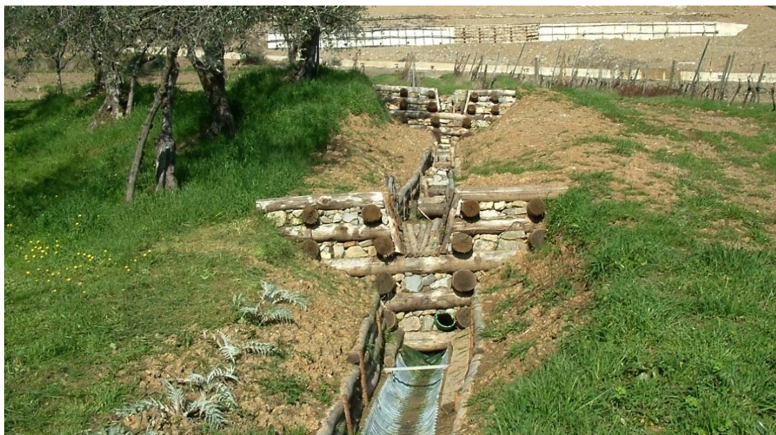
Fig. 38 – Consolidamento di un versante tramite un sistema di canalette superficiali in legname-pietrame nella porzione superiore e in lamiera nella porzione inferiore (località San Gennaro, Capannoni – LU – Foto febbraio 2004) -
