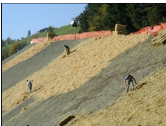
Fig. 18 – Intervento di semina nero-verde su una scarpata a Proves (BZ): a sinistra distribuzione dello strato di paglia e semina, a destra il risultato dopo tre mesi (immagini tratte dal sito internet www.Vandeborre.it ) -
