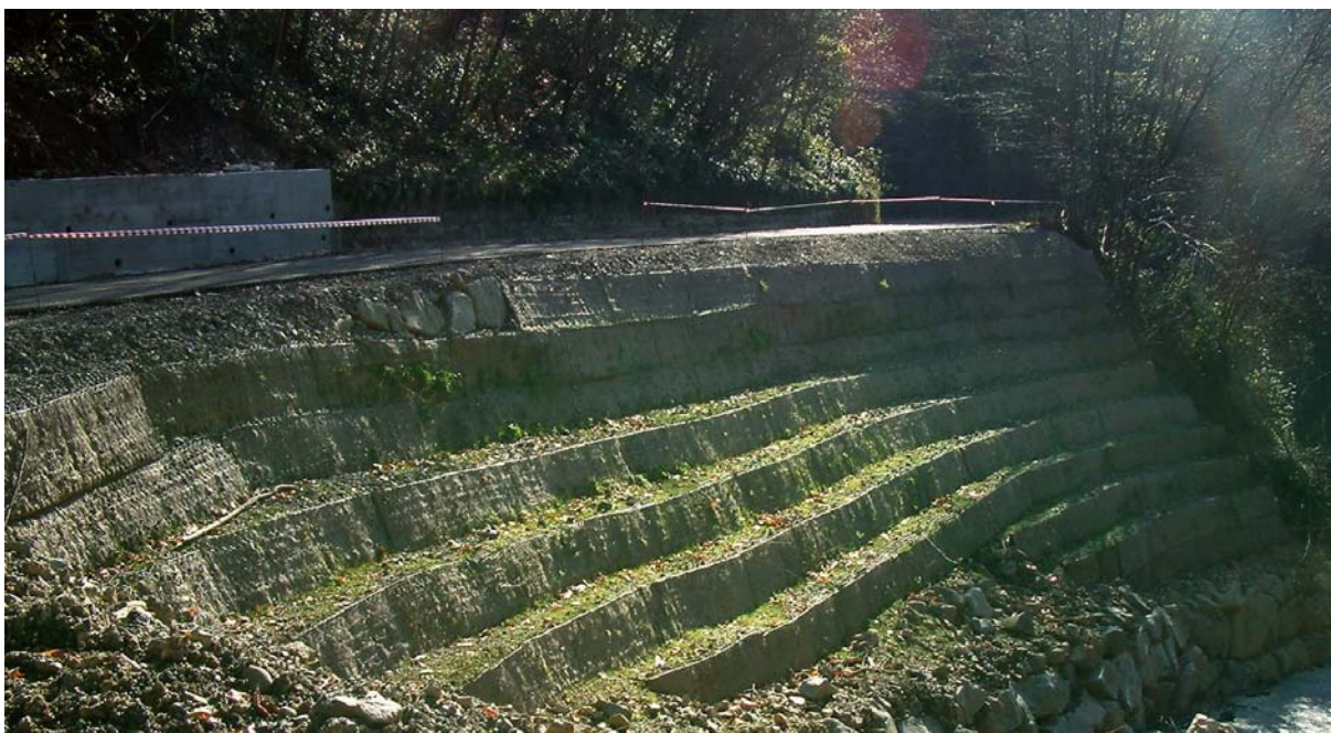
Fig. 105 – Stabilizzazione di fenomeno franoso tramite l'utilizzo di terre armate in località Renicci nel comune di Marliana (PT). La faccia a vista della terra armata è stata rivestita tramite intervento di rinverdimento (B1c) -
