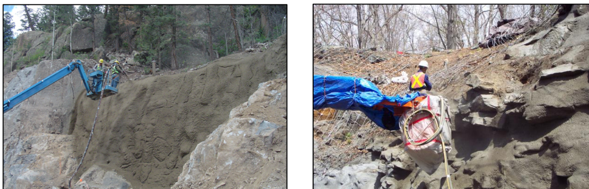
Fig. 103 – Utilizzo di cemento proiettato per la stabilizzazione di pareti rocciose; l'immagine di destra è tratta dal sito internet www.dot.state.co.us (Colorado Department of Transportation), quella di destra dal sito www.janod.biz (Janod Inc.) -
