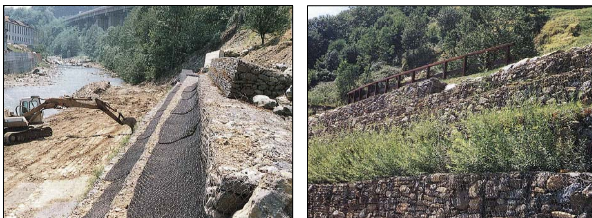
Fig. 70 – Utilizzo di gabbioni nella stabilizzazione della sponda sinistra del torrente Stura nel comune di Campoligure (GE). Successivamente alla realizzazione della gabbionata, sono state messe in posa delle talee di salice (tra la pedata e l'alzata della gradonatura) ricoperte con terreno protetto con materiale geosintetico (geostuoia, vedi interventi B1a); la fascinata di talee è stata poi ancorata alla gabbionata tramite una rete metallica a maglia esagonale. A sinistra fase di realizzazione dell'opera, a destra opera a sei mesi dal completamento (da REGIONE LIGURIA, 1997) -
